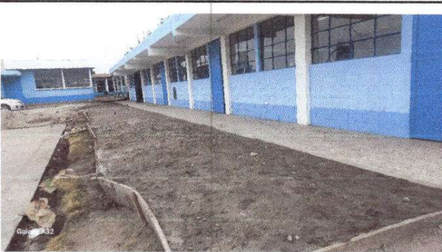
Foto 4: Reparación de planchas de concreto de patio
